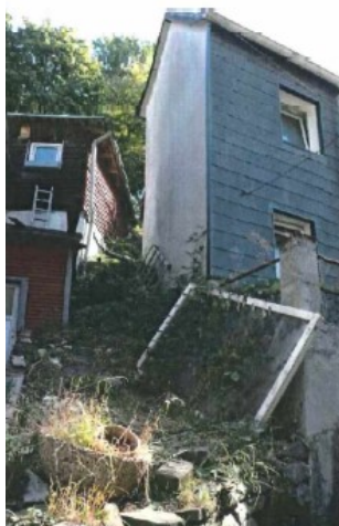
Ansicht Süd-West Ecke
